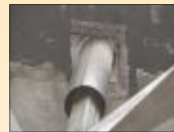
Einbau mit Aussparung oder Kernbohrung
