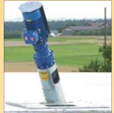
Gasabdichtung mit Tauchrohr aus Kunststoff oder Inox
